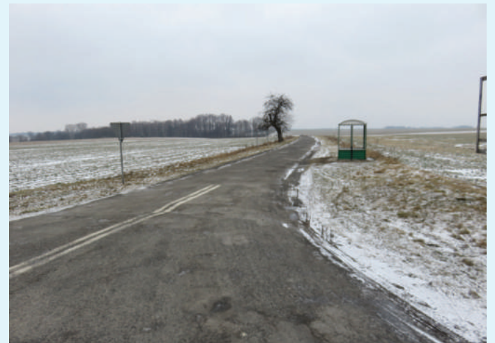
W 2017 roku zaplanowano przebudowę drogi Szymanów-Zawadka
