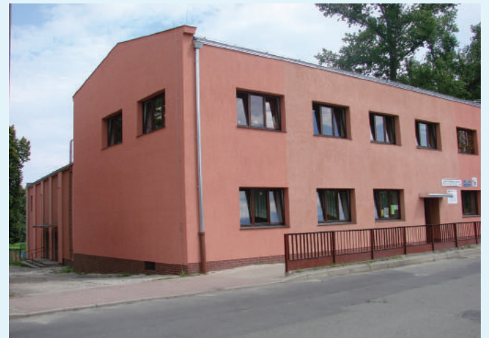
Uwzględniono także remont Gminnego Ośrodka Kultury
